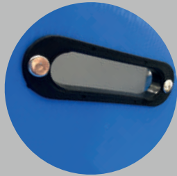
Agarraderas plásticas aseguradas con remaches metálicos.
